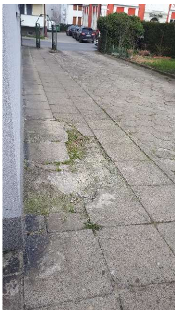
Zdjęcie nr 2 – wymiana płytek chodnikowych – 8szt.
